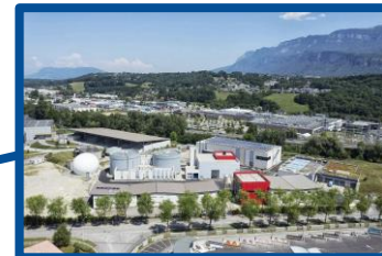
Projet de récupération des eaux usées de la station d'épuration de Chambéry
