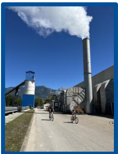
Récupération des eaux de condensats depuis 1999 (20 000m 3 /an)
